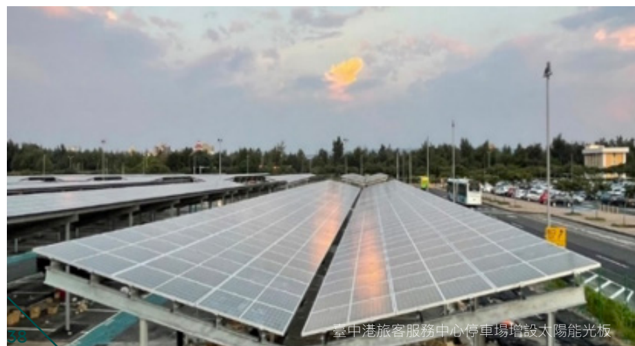
臺中港旅客服務中心停車場增設太陽能光板
